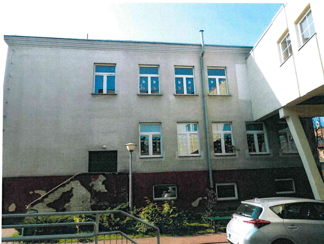
Elewacja szczytowa budynku, północna.
