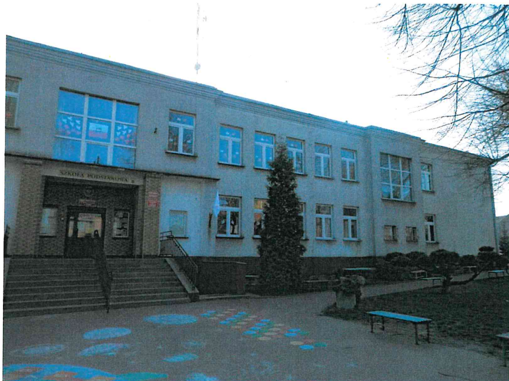
Elewacja frontowa podłużna budynku, zachodnia.
