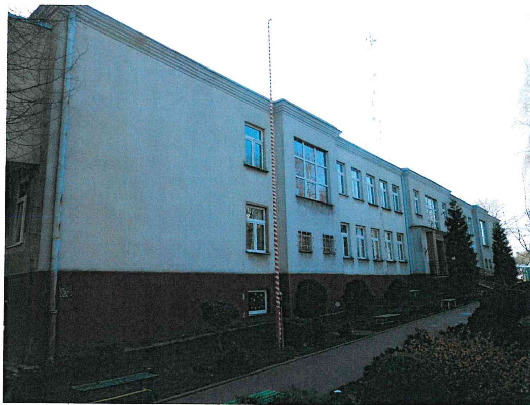
Elewacja podłużna budynku, zachodnia.
