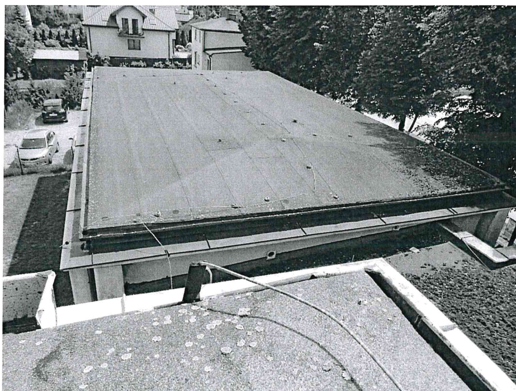
Dach budynku Biblioteki w osi wschód - zachód.
