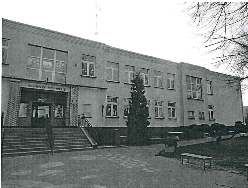
Elewacja frontowa podłużna budynku, wschodnia.
