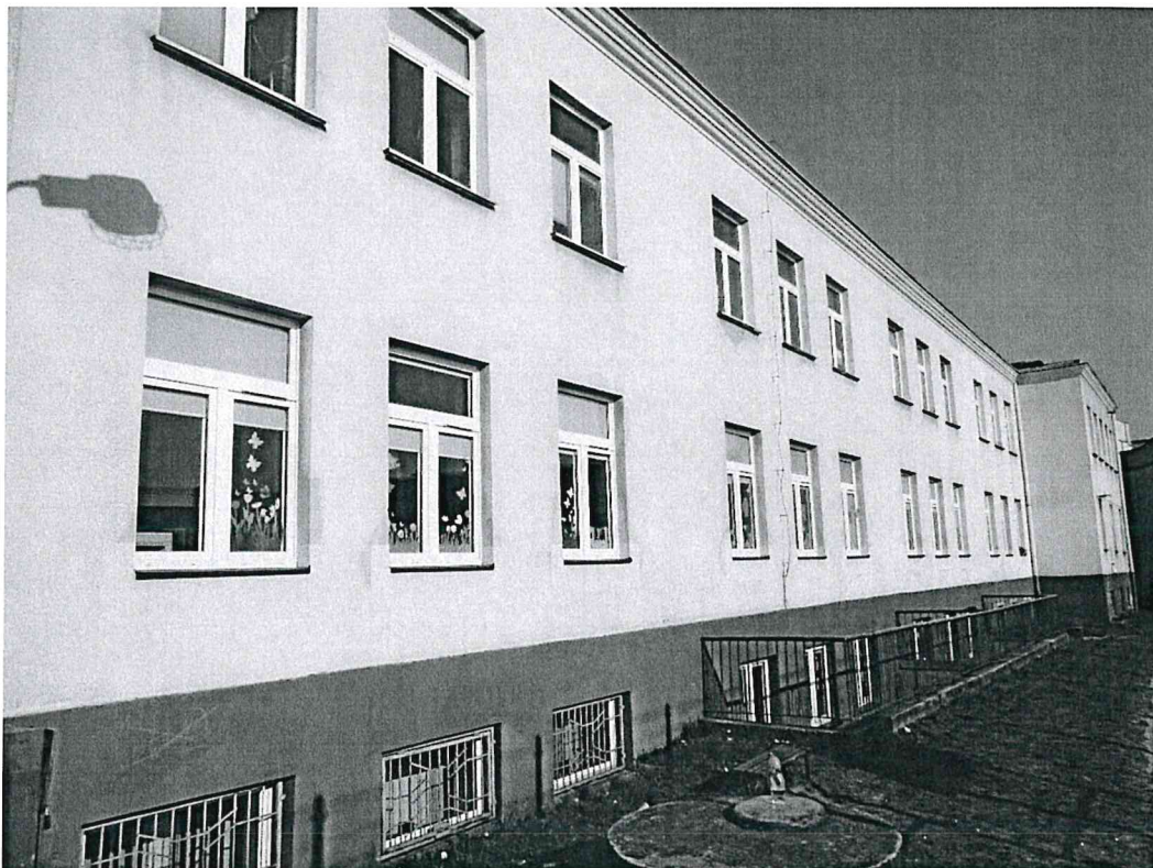
Elewacja podłużna budynku, zachodnia.
