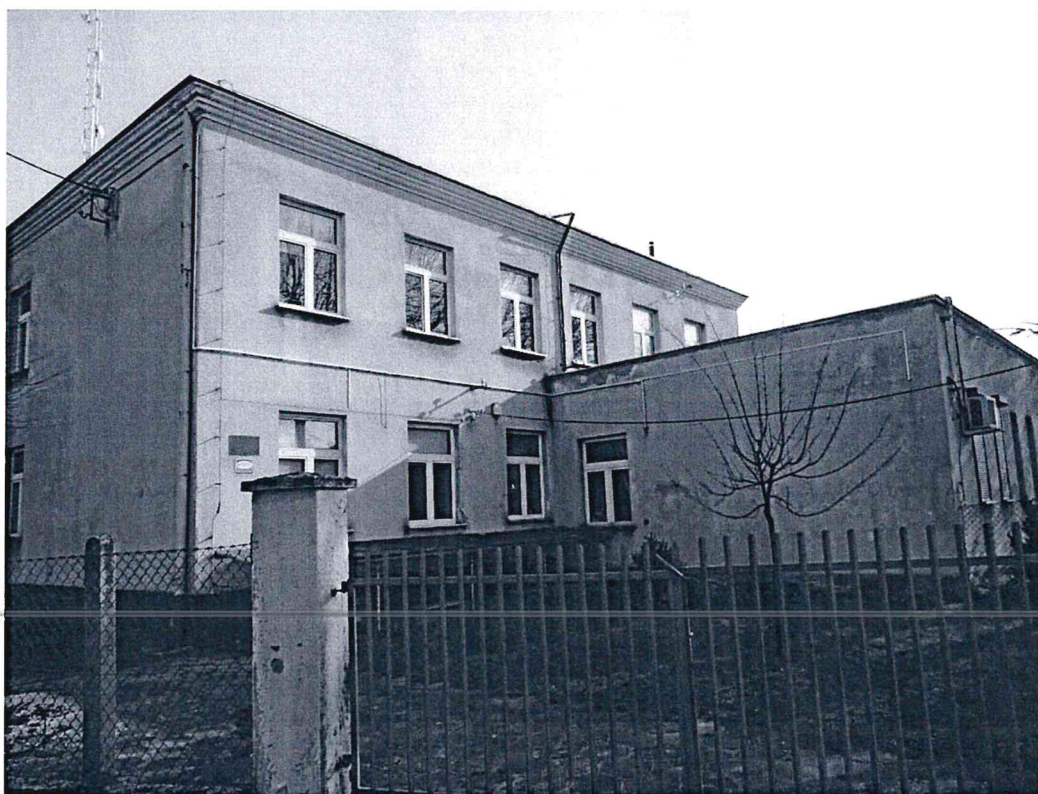
Elewacja podłużna, frontowa budynku Biblioteki, północna.
