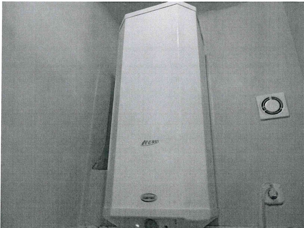
Elektryczny ogrzewacz wody GALMET, typ: SG Heros o pojemności 80,0 litrów.
