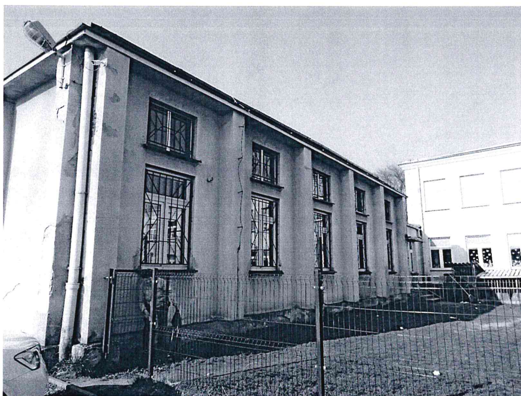
Połączenie budynków, elewacja południowa.
