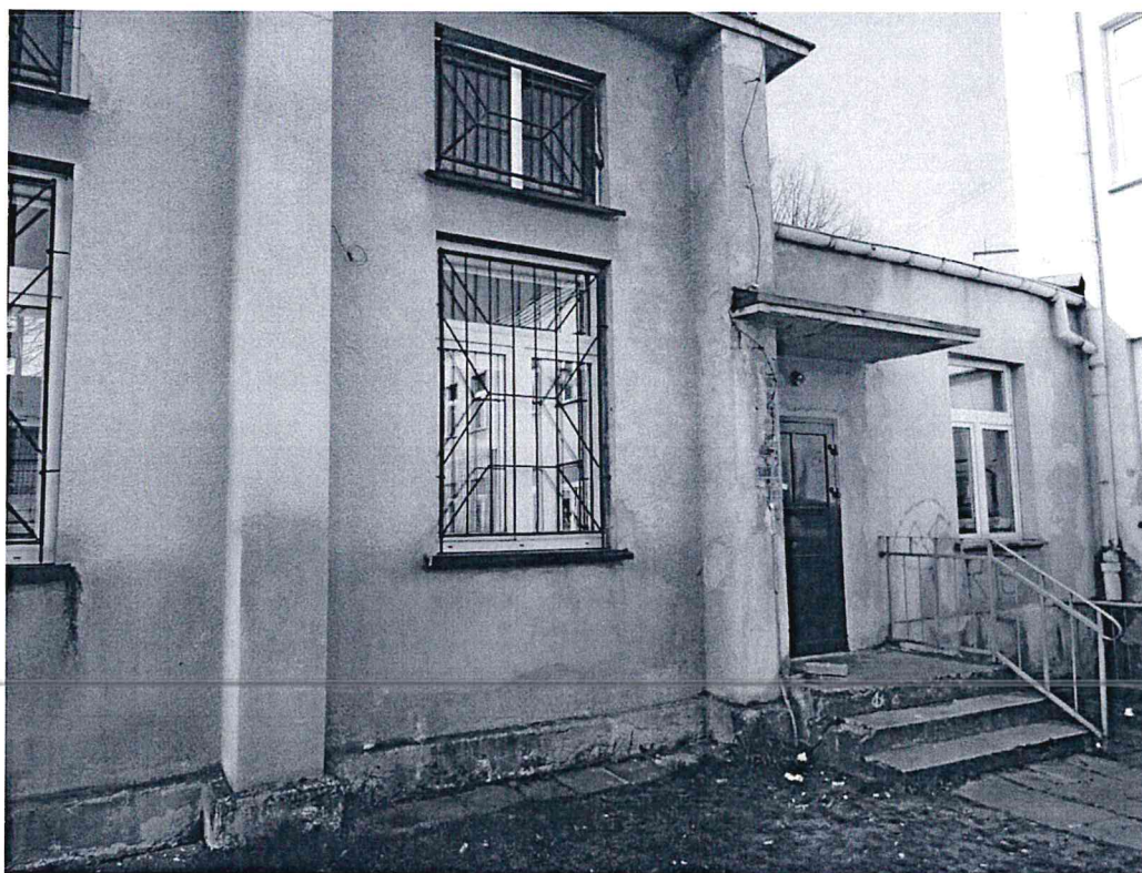
Elewacja podłużna budynku, zachodnia.
