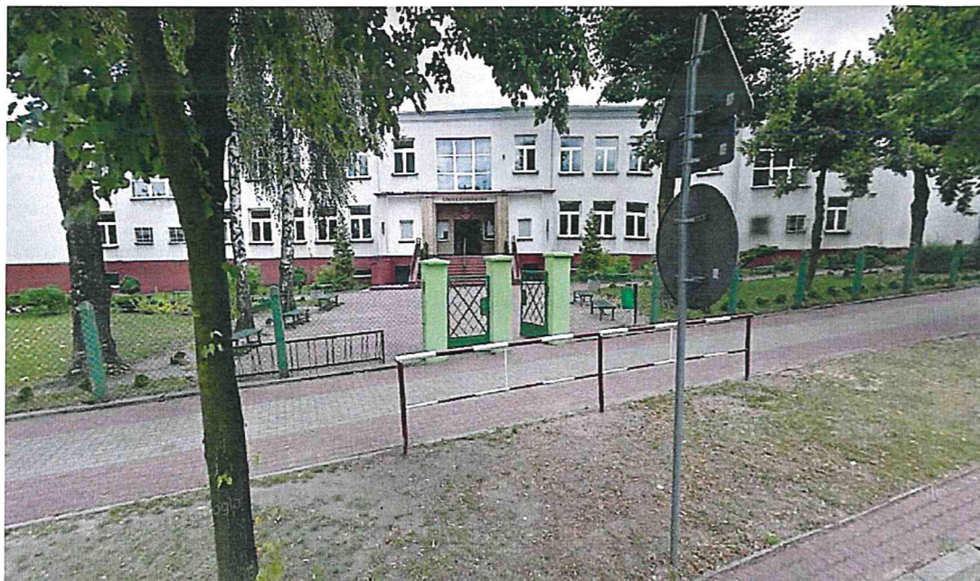
Wejście główne do budynku „B” szkoły
