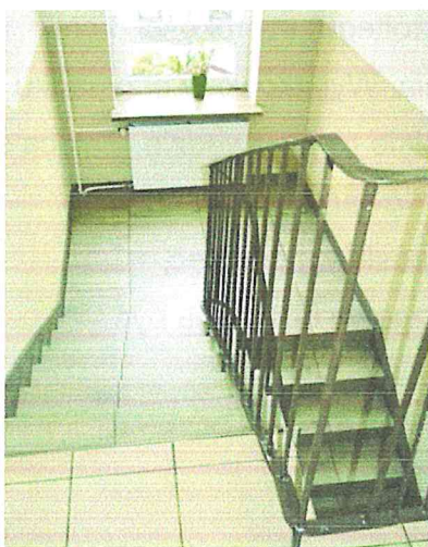
Zdjęcie 8: Schody prowadzące w dół. Na poziomie spocznika okno z szerokim parapetem umieszczonym ponad grzejnikiem. Z prawej strony balustrada zamontowana od strony duszy schodów.
