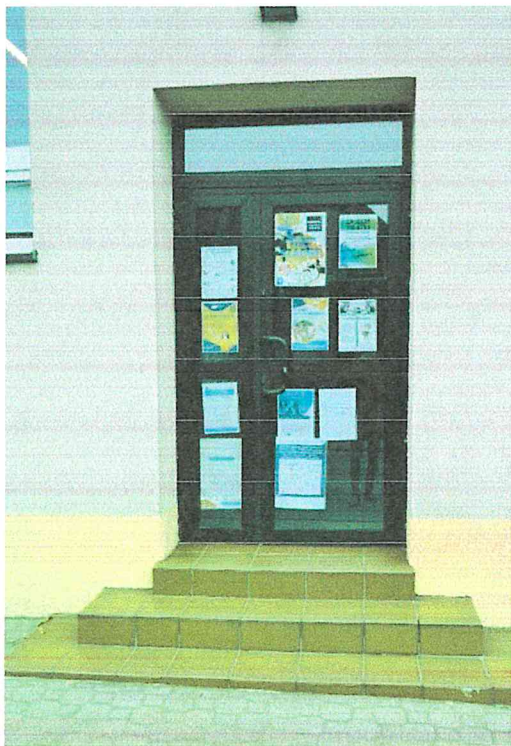
Zdjęcie 6: Drugie wejście do budynku. Rama skrzydła drzwiowego w kolorze brązowym z umieszczonymi na drzwiach plakatami. Przed drzwiami trzy stopnie schodów wejściowych.
