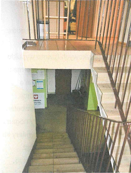
Zdjęcie 9: Schody wewnętrznej klatki schodowej. Nieoznaczona krawędź górnego spocznika.
