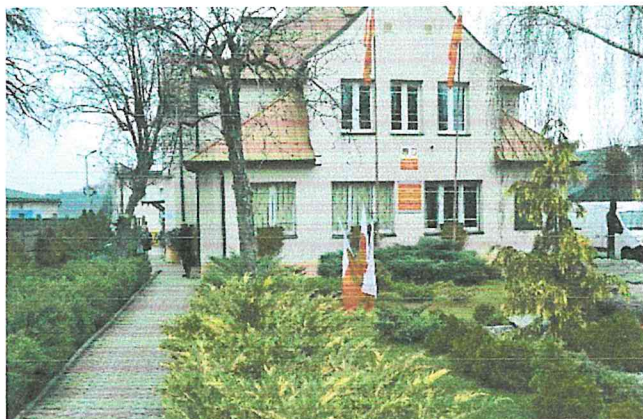
Zdjęcie 1: Utwardzony ciąg pieszki prowadzący do wejścia głównego do Urzędu. W głębi budynek z czerwonymi tablicami.
