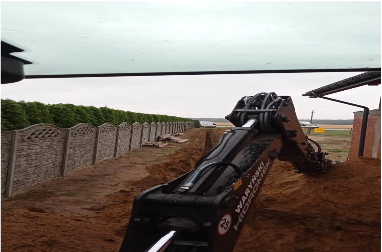
Budowa przyłączy wodociągowych
