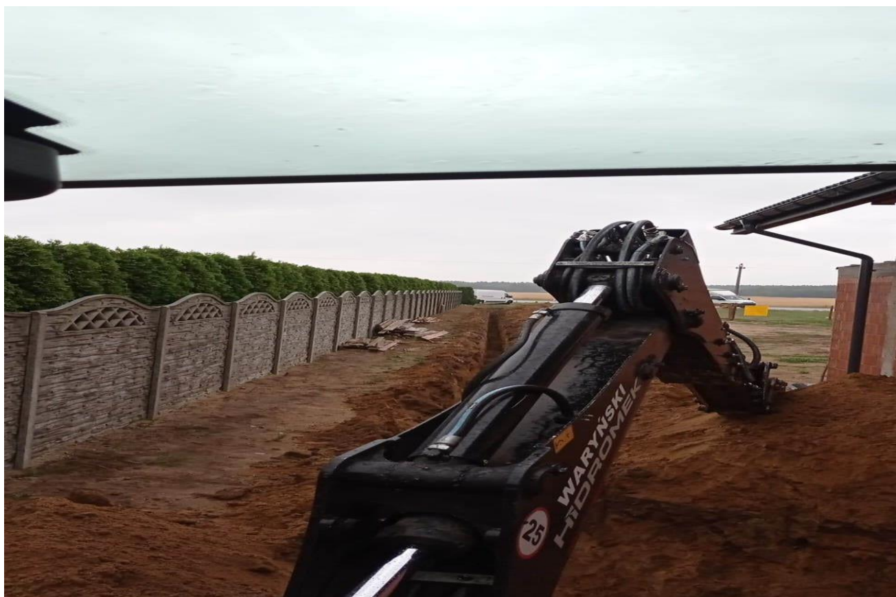
Budowa przyłączy wodociągowych
