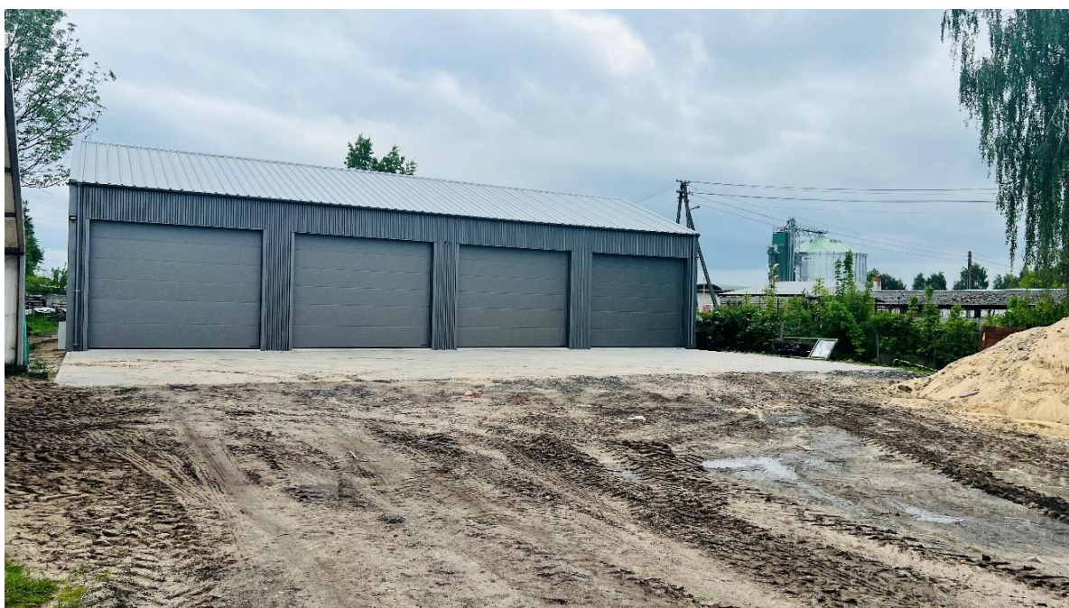
Hala magazynowa na PSZOK – ZGK w Rządowego Funduszu Inwestycji Strategicznych POLSKI ŁĄD
